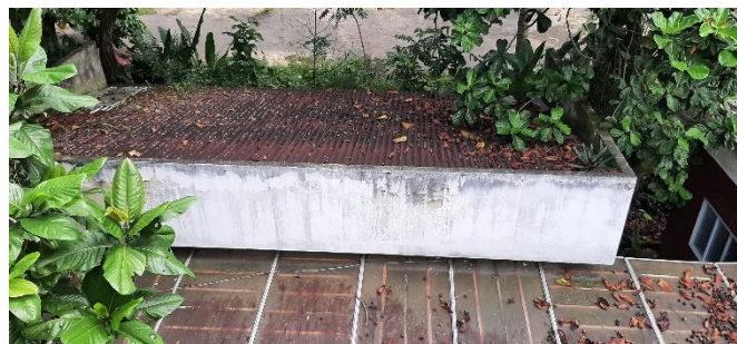
Telhado do prédio anexo
