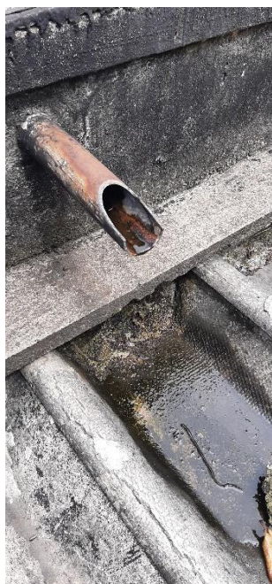
Dreno da laje sobre telhas corridas
